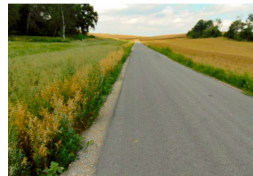
Drogi transportu rolnego wykonane w ramach zagospodarowania poscaleniowego, fot. Powiat Raciborski
