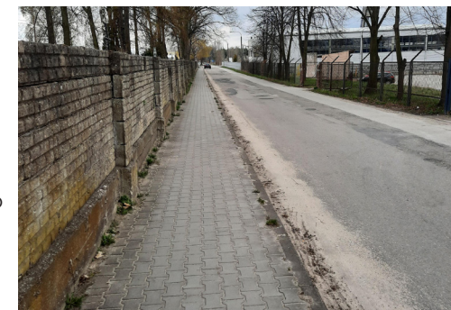
ul. Przemysłowa w Szczekocinach przed realizacją, fot. Natalia Karoń
