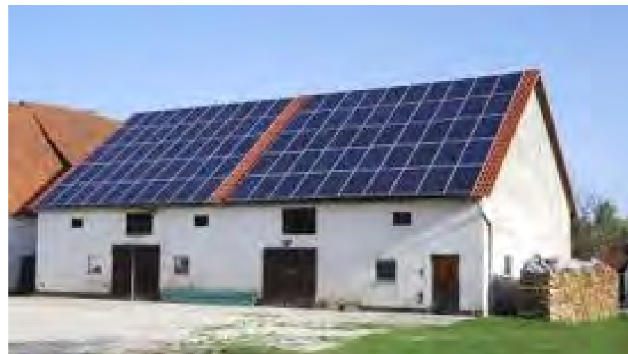
Zaadoptowany dach na potrzebę paneli fotowoltaicznych.
