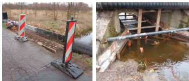
Most na Stradomce w trakcie przebudowy
